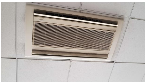
Obr. 20: vnitřní část split jednotky
